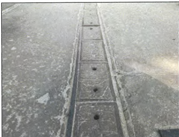
รูปที่ 24 รางระบายน้ำทิ้งไปยังระบบบำบัด น้ำเสียของโรงงานน้ำตาล
