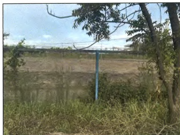
รูปที่ 18 โครงสร้างเหล็กติดตาข่ายดักฝุ่น ล้อมรอบพื้นที่ลานกองถ่าย
